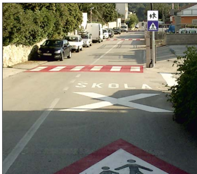
Slika 11. Pješački prijelaz s crvenom podlogom i prometnim znakom H46 – „djeca na cesti“ kao oznakom na kolniku
