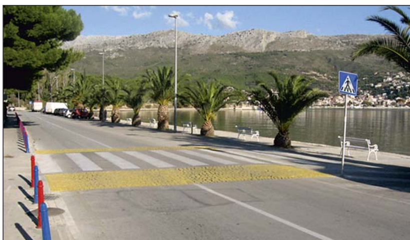
Slika 20. Uzdignute plohe za smanjenje brzine s obilježenim pješačkim prijelazom i obojenim prilaznim rampama od drugačijeg materijala
