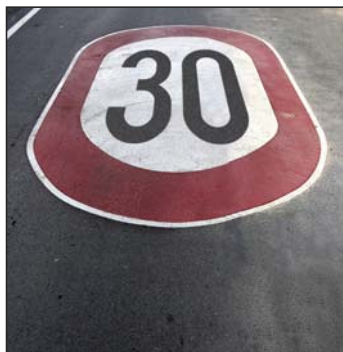
Slika 14. Oznaka na kolniku H45 – „ograničenje brzine“ izvedena kao umjetna izbočina za smirivanje prometa
