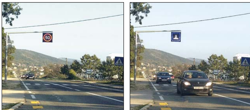
Slika 6. i 7. Kombinacija promjenjivog prometnog znaka C02–, „obilježen pješački prijelaz“ i znaka B31–, „ograničenje brzine na 50 km/h“ na konzolnom nosaču iznad pješačkog prijelaza kod OŠ u Cisti Velikoj koji se naizmjenično uključuju
